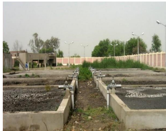
الشكل 8-16: تقنية التجفيف الطبيعي لمعالجة الحمأة.
