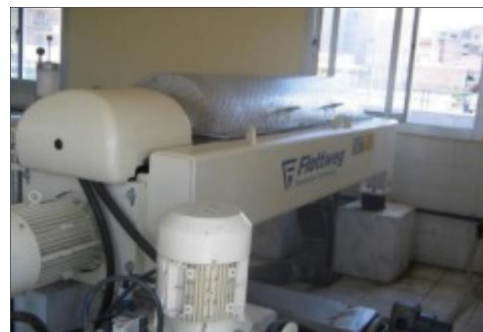
الشكل 8-17: تقنية الطرد المركزي لمعالجة الحمأة.
