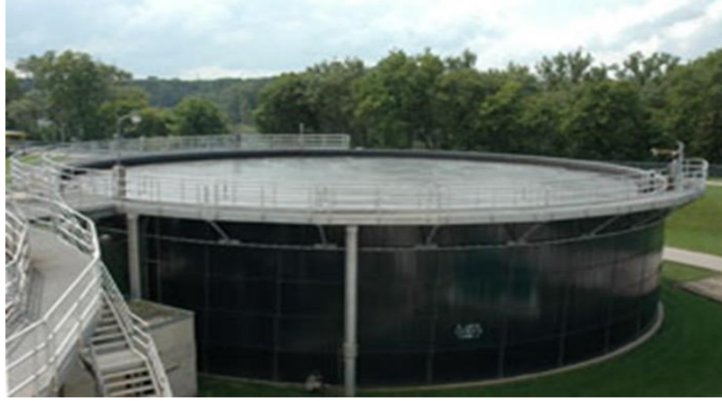
الشكل 8-13: تقنية التسخين أو التكتيف لمعالجة الحمأة.
