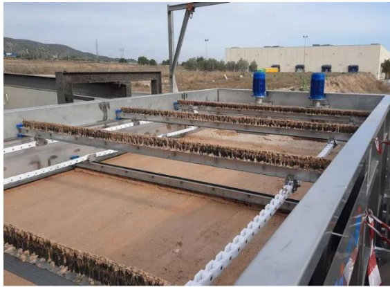
الشكل 8-14: تقنية التعميم لمعالجة الحمأة.
